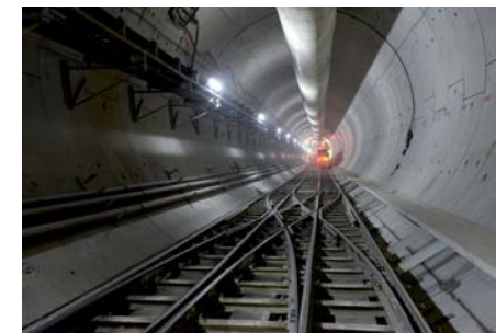
Interior túnel de la Cabrera
