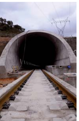
Boca túnel de la Cabrera
