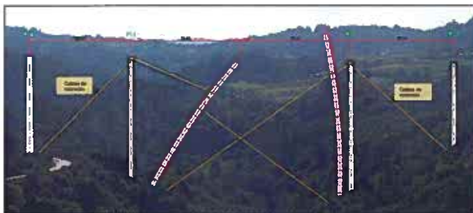
Descenso del semiarco hasta su posición final.
