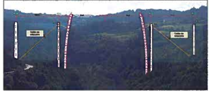
Retirada de las barras de anclaje intermedias de los semiarcos a las pilas.
