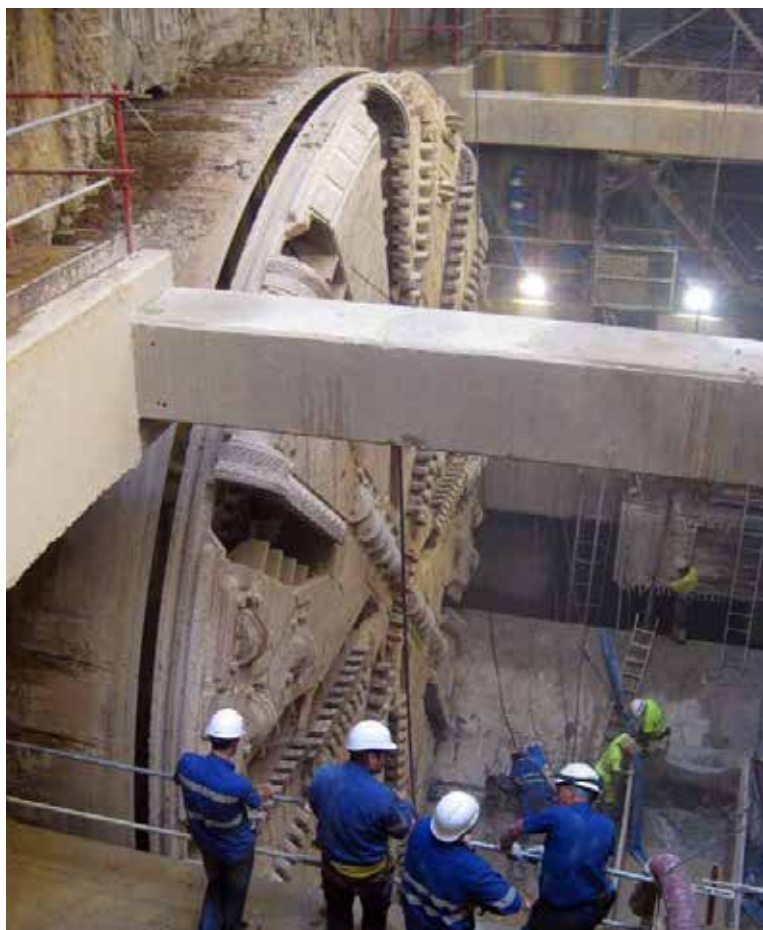
Tuneladora Gerunda en el pozo de mantenimiento de la Devesa
