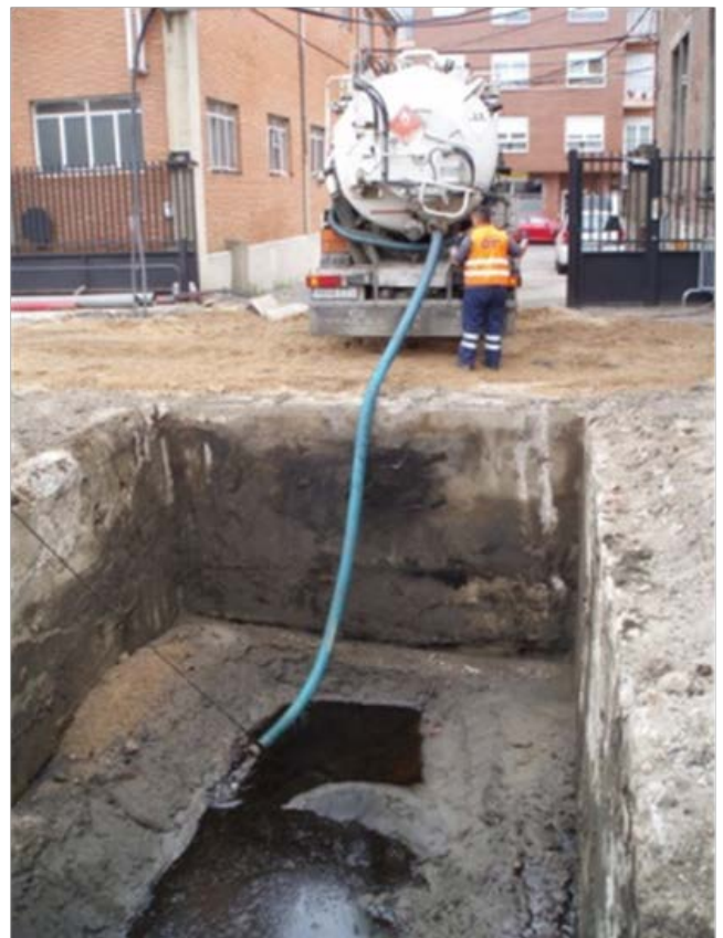
Recuperación de producto libre del hueco de una excavación
