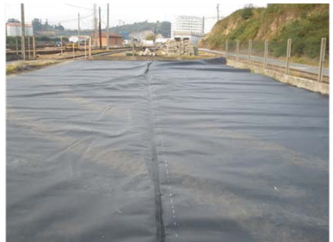
Colocación geotextil para landfarming
