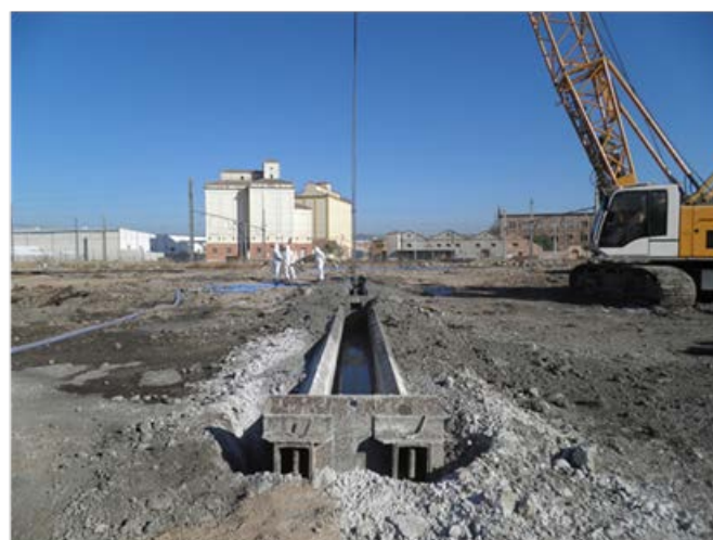
Ejecución barrera permeable
