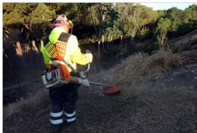
Labores de limpieza en las proximidades de la vía
