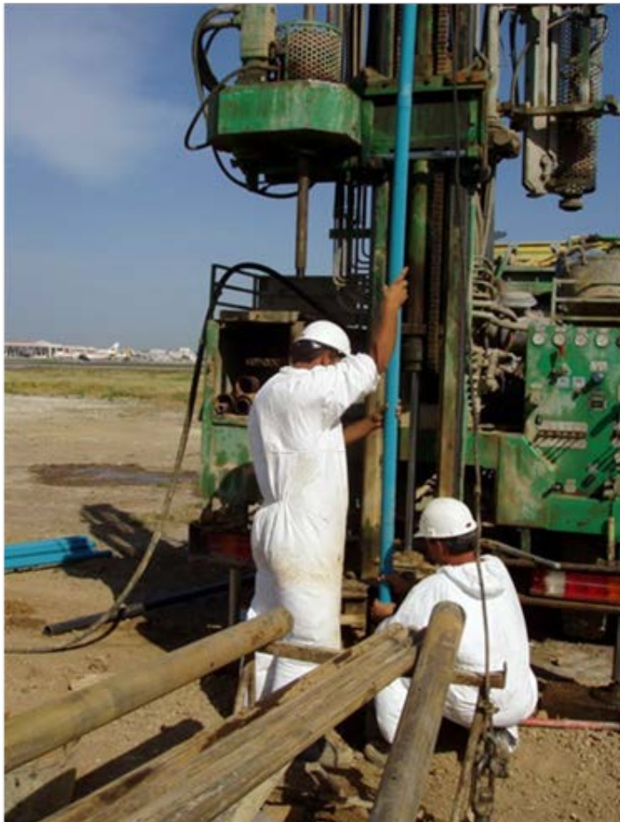
Instalación de piezómetro en un sondeo
