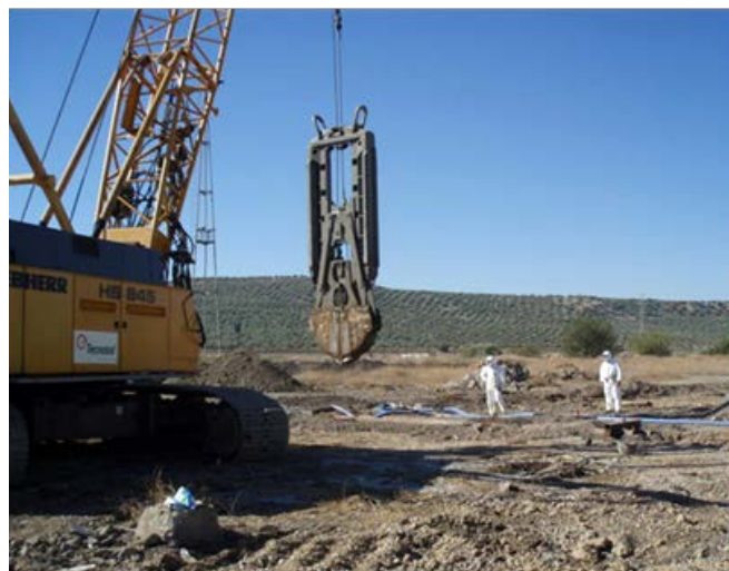
Ejecución de muro pantalla (Andújar)
