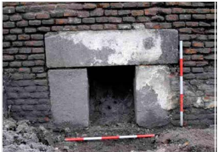
Salida aliviadero en el interior del vaso de la Esclusa
