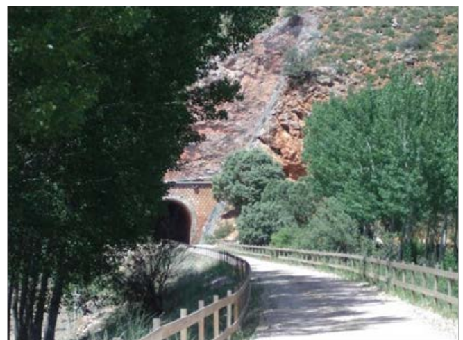
Túnel de El Jardín en la Vía Verde de la Sierra Alcaraz (Albacete), Fuente: Programa Vías verdes
