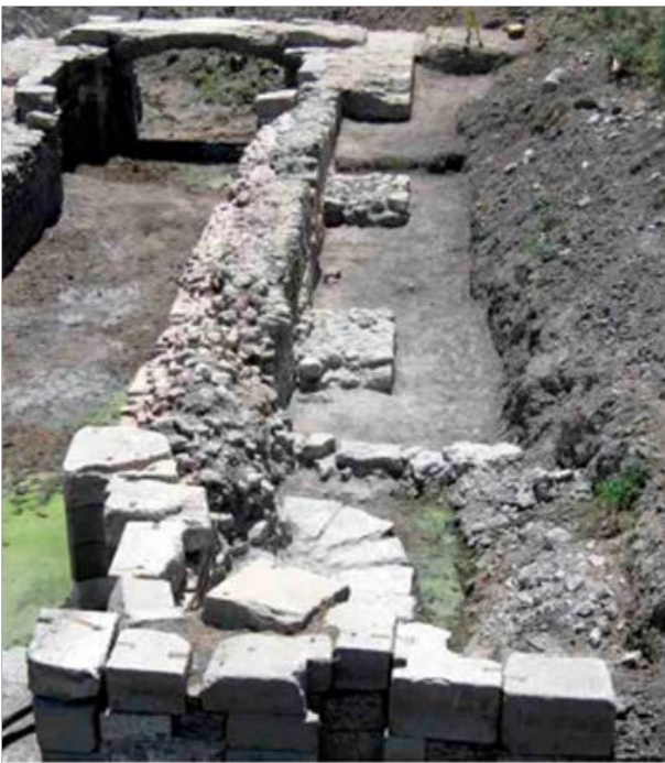
Vistas generales del muro de contención
