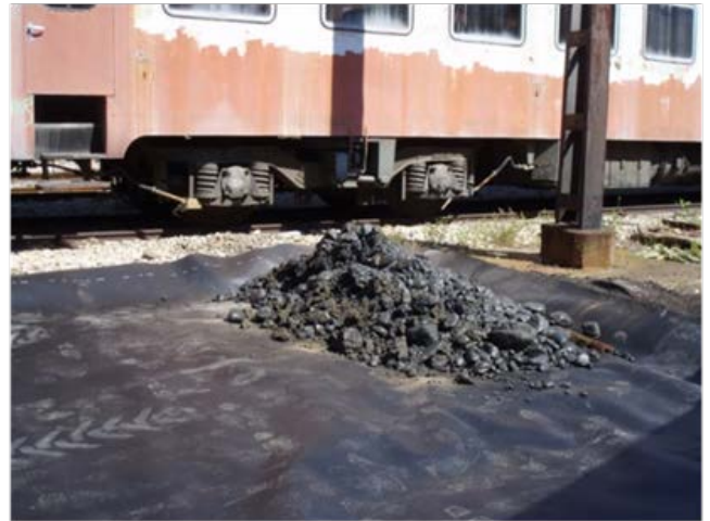
Acopio de tierras contaminadas para su gestión posterior
