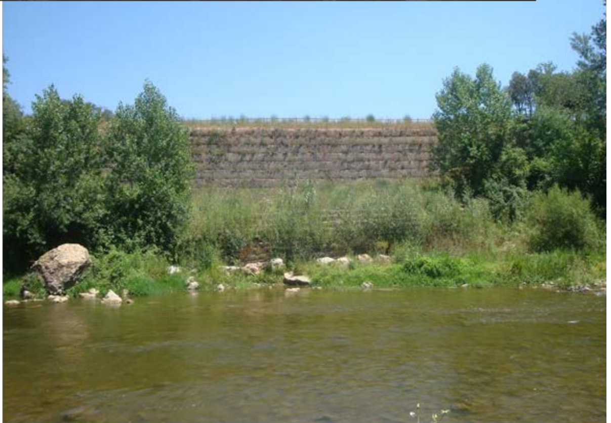
Muro "Kraimer" y muro verde actual
