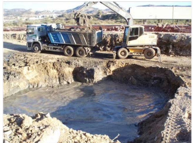
Excavación de suelo afectado
