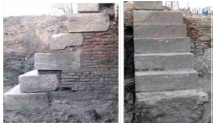
Vistas de los estribos (U.E. 7002 y 7003) del Gallipiente.
