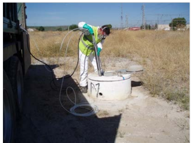
Instalación de bomba neumática en pozo de bombeo
