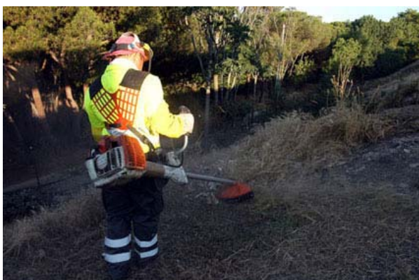
Trabajos de limpieza de la vegetación
