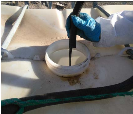
Trabajos realizados en la antigua base de creosotado de Andújar
