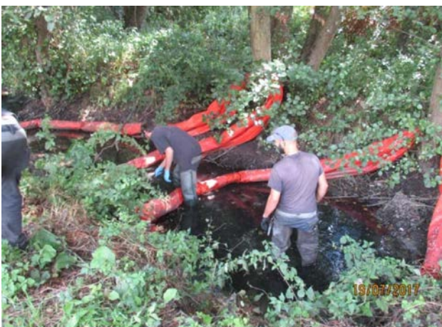
Colocación de barreras en el río Mesón de Calvos
