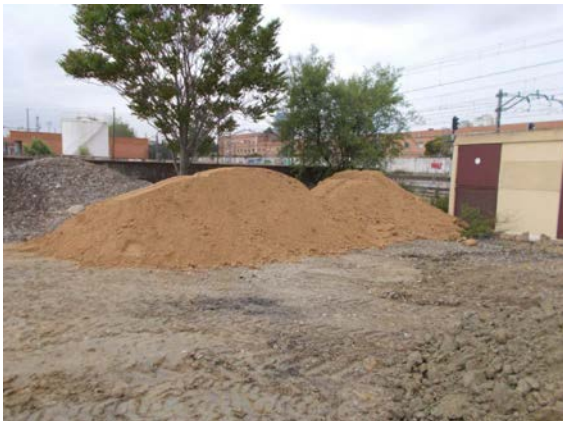
Trabajos de excavación selectiva en Fuencarral (Madrid)
