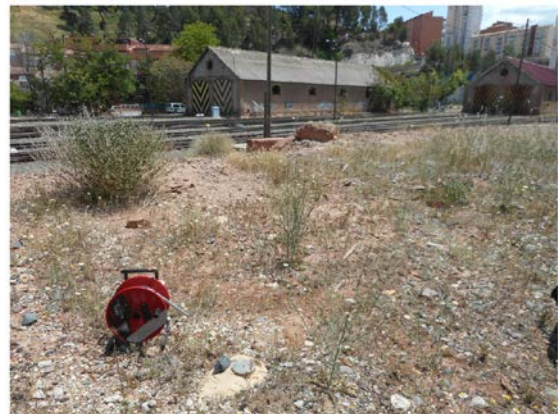
Trabajos en los terrenos de la estación de Adif en Teruel
