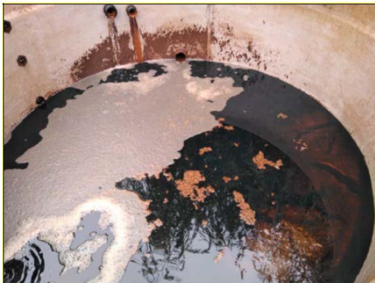
Trabajos de descontaminación de la zona de suministro de combustible y talleres de la estación de FFCC de La Coruña
