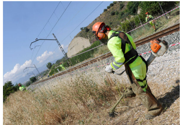
Trabajos de limpieza de la vegetación
