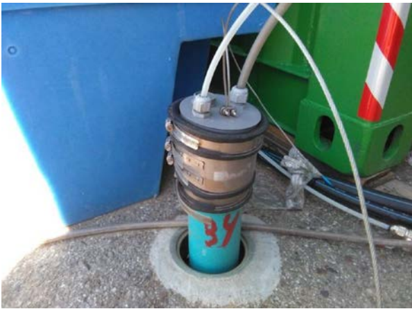
Piezómetro instalado en la instalación de combustible de Adif en Sevilla
