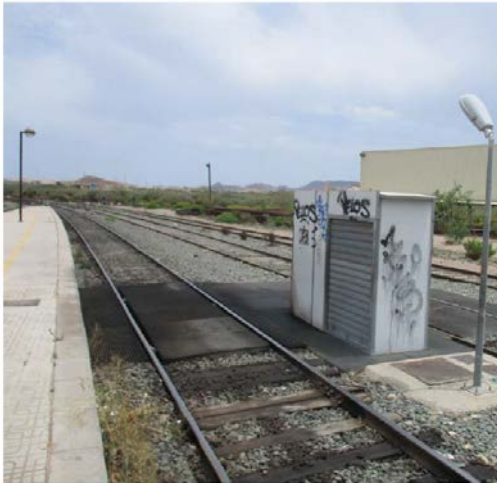
Zona de suministro de combustible de las instalaciones de Adif en Cartagena (Murcia)
