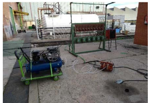
Zona de suministro y almacenamiento de combustible en la Base de Mantenimiento Integral de Madrid
