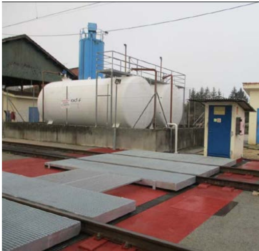
Detalle de la zona de suministro de combustible de la estación de Monforte de Lemos (Lugo)
