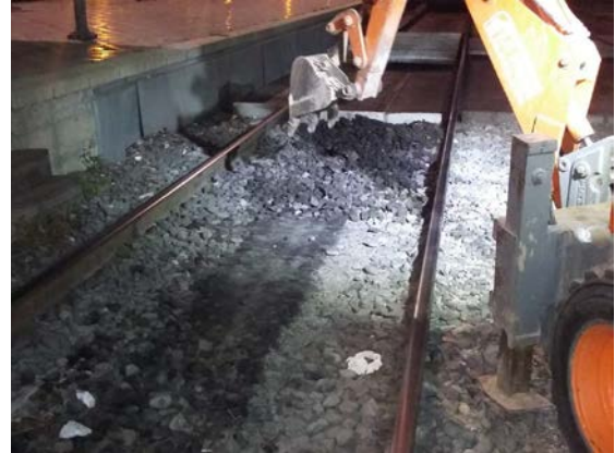
Trabajos de excavación selectiva en la estación de Murcia
