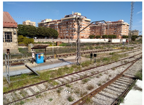
Figura 7. Punto de suministro de combustible (Almería).
