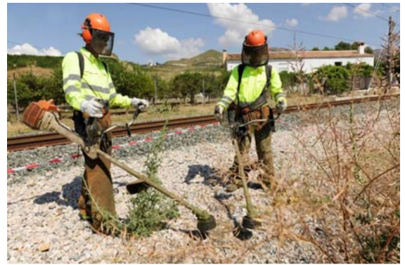
Figura 17. Trabajos de limpieza de la vegetación en los márgenes de la vía.
