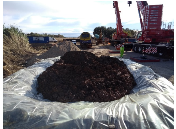
Figura 15. Trabajos de recogida de suelo afectado por derrames de hidrocarburo (Puigverd).
