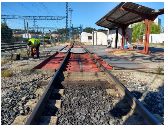
Figura 8. Punto de suministro de combustible (A Coruña).
