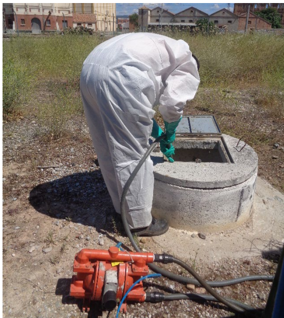
Figura 5. Inspección de pozos de captación de creosota (Andújar).
