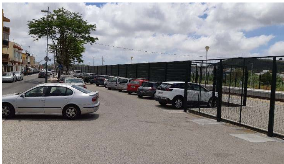
Figura 46. Pantallas acústicas ejecutadas en la Barriada de la Estación
