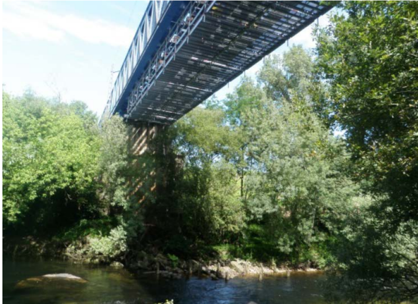
Figura 48. Río Tera a su paso por el puente ferroviario
