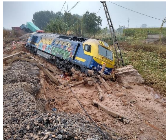
Figura 33. Descarrilamiento de convoy ferroviario (Puigverd, Lleida)
