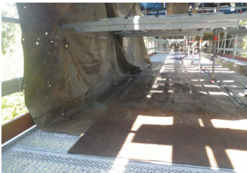
Figura 49. Vista interior del encapsulado del andamio
