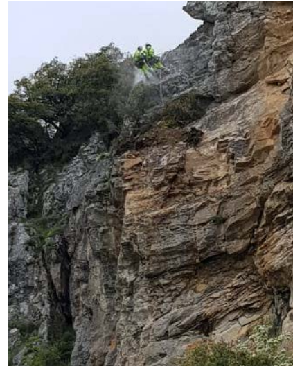
Figura 45. Trabajos manuales de estabilización del talud
