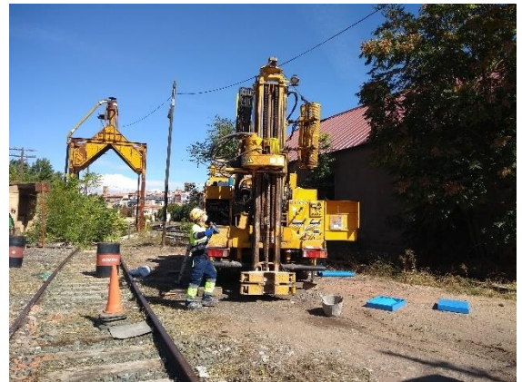
Figura 28. Perforación de sondeos (Teruel).
