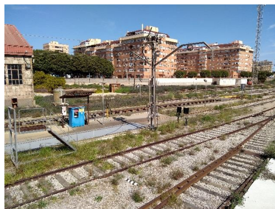
Figura 30. Punto de suministro de combustible (Almería).
