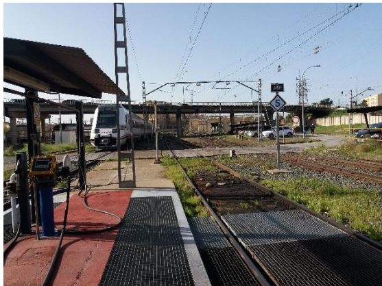
Figura 24. Punto de suministro de combustible de Sevilla
