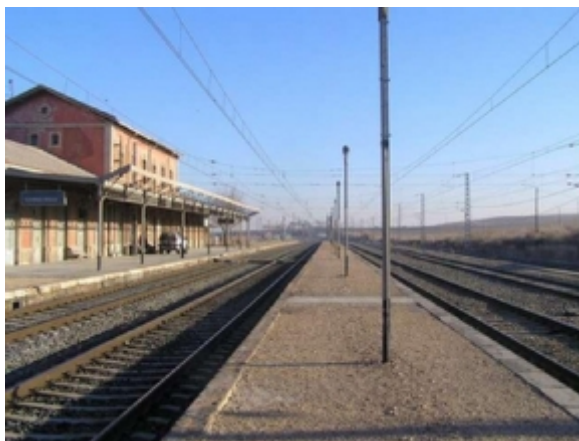
Figura 52. Instalación logística de Castillejo-Añover (Madrid)
