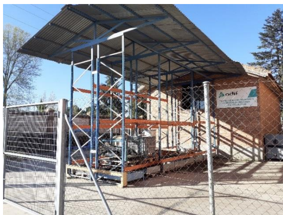
Figura 17. CAR en el Centro de Tecnología de Vía en Valladolid
