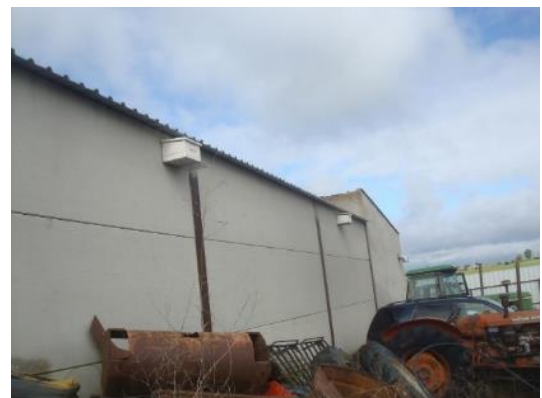
Figura 42. Colocación de 2 cajas en la finca "Los Serranos"
