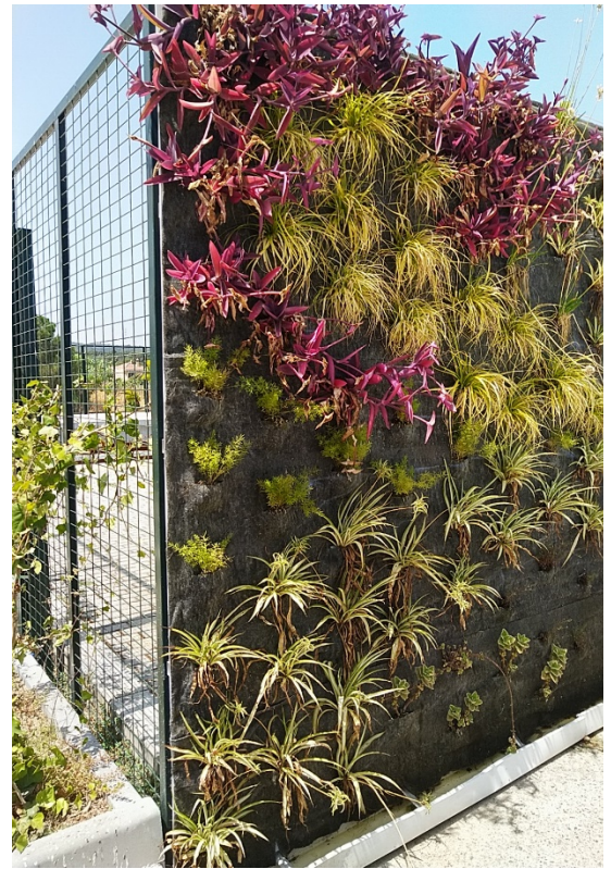
Figura 47. Jardín vertical ejecutado en la Barriada de la Estación
