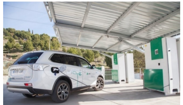
Figura 7. Imagen de una ferrolinera.
