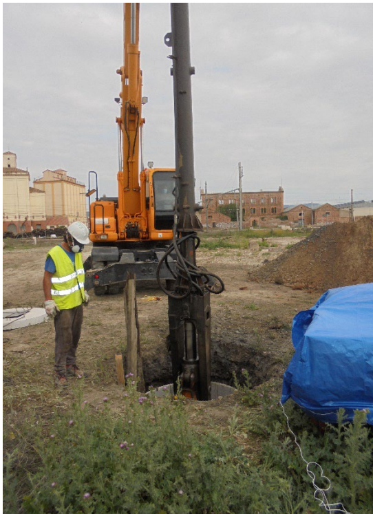
Figura 15. Trabajos de descontaminación en la antigua base de creosotado de Andújar
