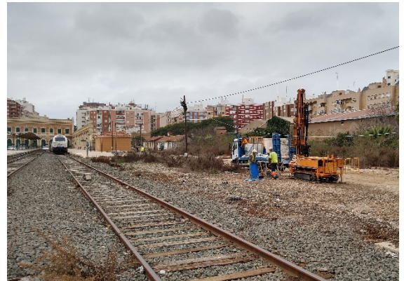
Figura 23. Perforación de sondeo
