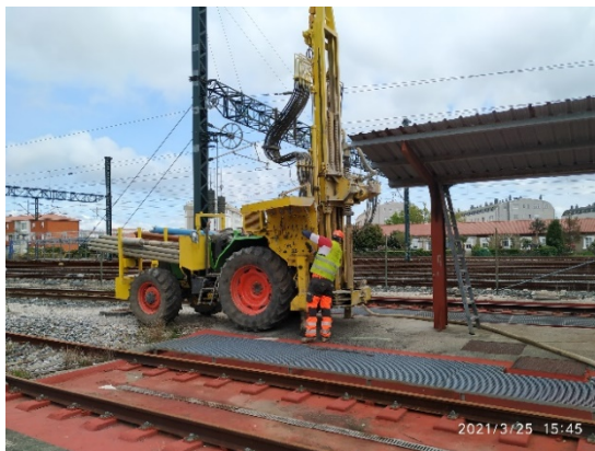
Figura 14. Perforación de sondeo en A Coruña
