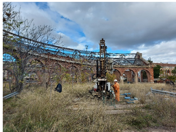
Figura 21. Perforación de sondeo en antigua plataforma giratoria
