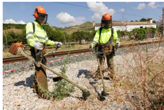
Figura 29. Trabajos de limpieza de la vegetación en los márgenes de la vía.
