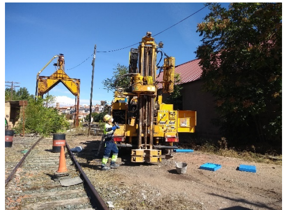
Figura 20. Perforación de sondeos (Teruel).
