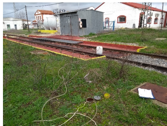
Figura 22. Trabajos de bombeo/purgado en el punto de suministro de combustible
