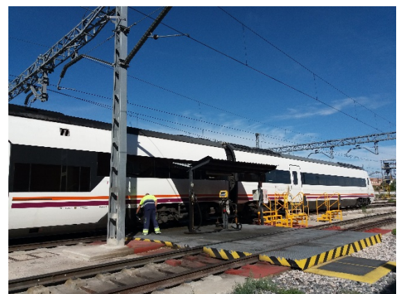
Figura 17. Punto de suministro de combustible (Fuencarral, Madrid)
