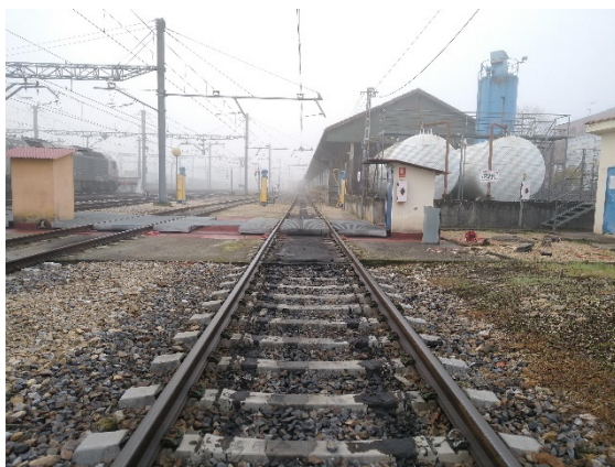
Figura 18. Vista general de la zona de almacenamiento y de suministro de combustible
