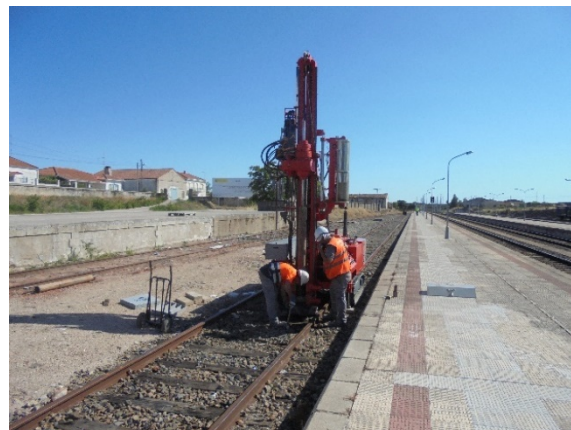
Figura 25. Perforación de sondeo
