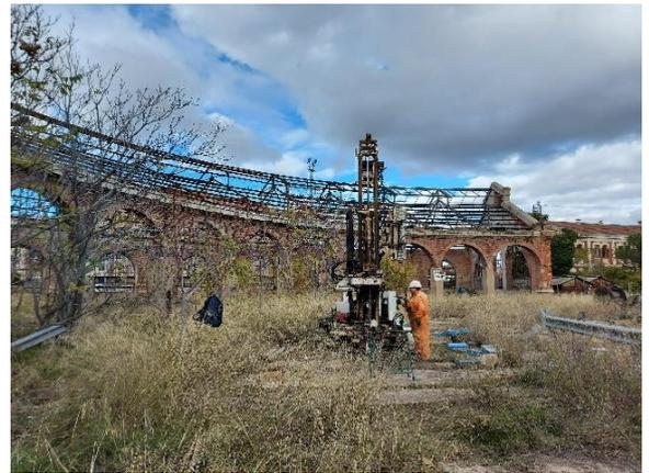
Figura 21. Perforación de sondeo en antigua plataforma giratoria
