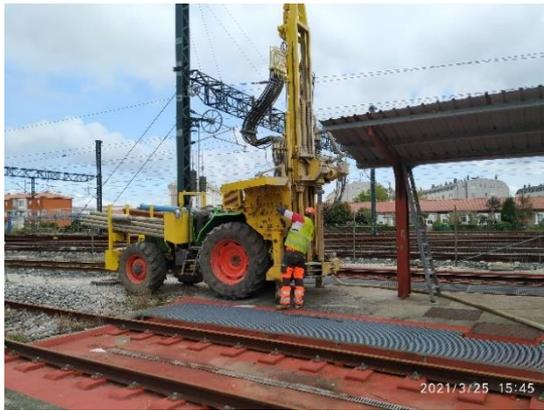
Figura 14. Perforación de sondeo en A Coruña
