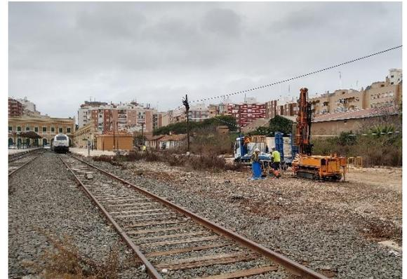
Figura 23. Perforación de sondeo
