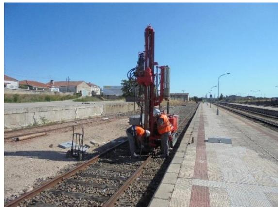
Figura 25. Perforación de sondeo
