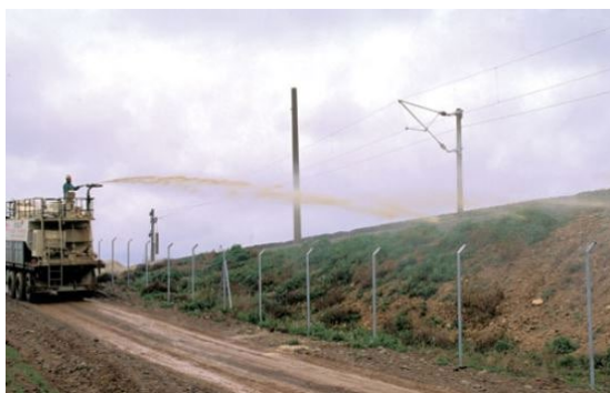
Figura 25. Actuaciones de protección contra incendios en los márgenes de la vía.
