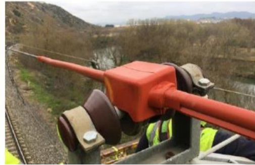
Figura 28. Medidas anti-electrocución instaladas en la línea convencional en La Rioja
