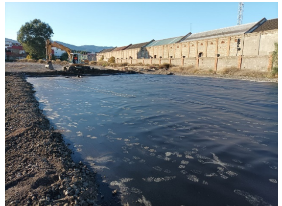
Figura 13. Lámina de geotextil para el tratamiento de suelos en el emplazamiento de Algeciras.
