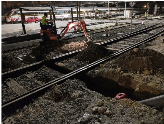
Figura 17. Instalación de canalizaciones de nuevos piezómetros en el emplazamiento de Sevilla.
