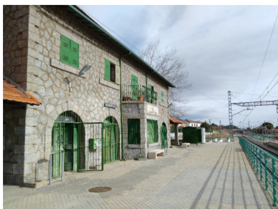
Figura 37. Estación de Zarzalejo (Madrid)
