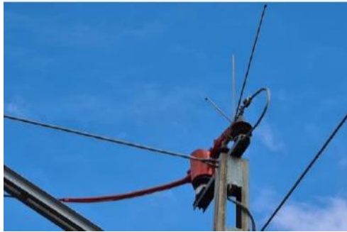
Figura 28. Medidas anti-electrocución instaladas en la línea convencional en La Rioja
