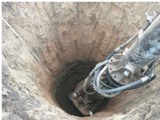
Figura 14. Perforación e instalación de un pozo de gran diámetro en Andújar.
