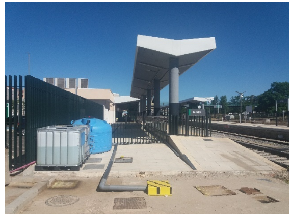
Figura 15. Módulo de tratamiento en el emplazamiento de Badajoz.
