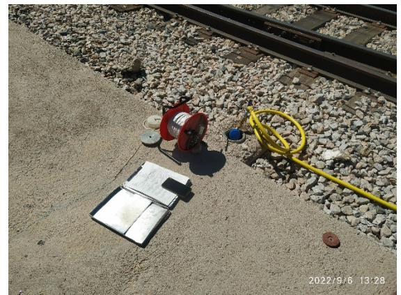
Figura 16. Ensayo de infiltración en el emplazamiento de Fuencarral.
