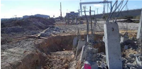
Figura 32. Pilotes prefabricados utilizados en la cimentación de las pilas del viaducto.
