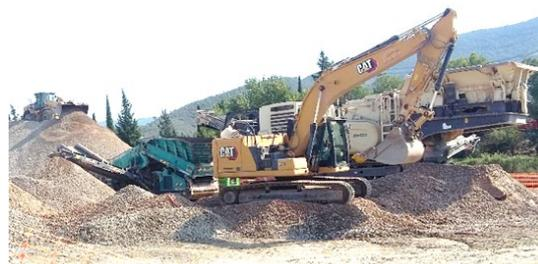
Figura 11. Operaciones de valorización *in situ* de RCDs
