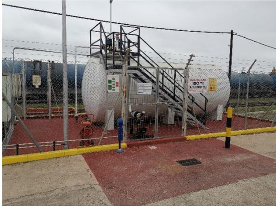
Figura 38. Depósito de suministro de combustible de Zafra
