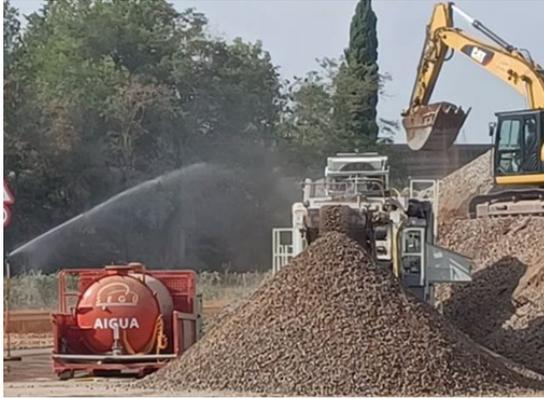
Figura 12. Cribado de balasto. Se ha asociado un sistema de riego por aspersion para minimizar la emisión de polvo
