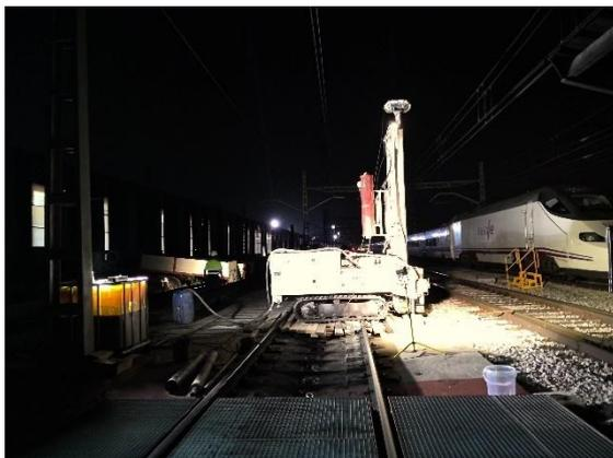
Figura 14. Ejecución de sondeo nocturno. Fuencarral
