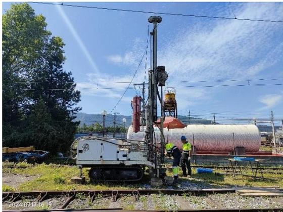
Figura 15. Ejecución de sondeo. Irún
