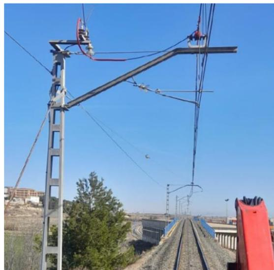
Figura 28. Elementos anti-electrocución colocados tras un incidente en la línea Madrid-Zaragoza-Portbou
