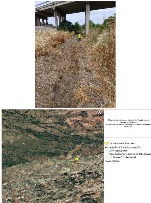
Figura 35. Seguimiento y control arqueológico de movimientos de tierras para un zanjeado de 34 km de Espeluy a Jaén para implantación de cable de comunicaciones, pasando junto al yacimiento de la ciudad ibero-romana de Cástulo
