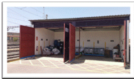
Figure 10. Waste Storage Centre (WSC) Málaga Los Prados
