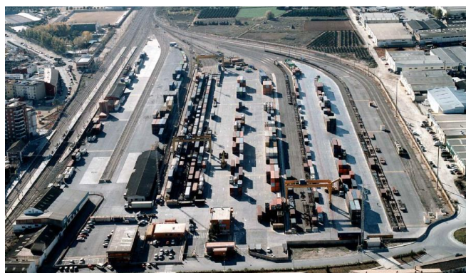
VISTA GENERAL NORTE DE LA T.T.M. DE SILLA
