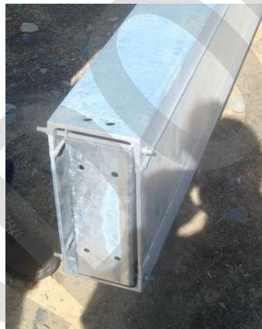
Figura 5. Chapa en U en la parte superior del poste cerrado.
