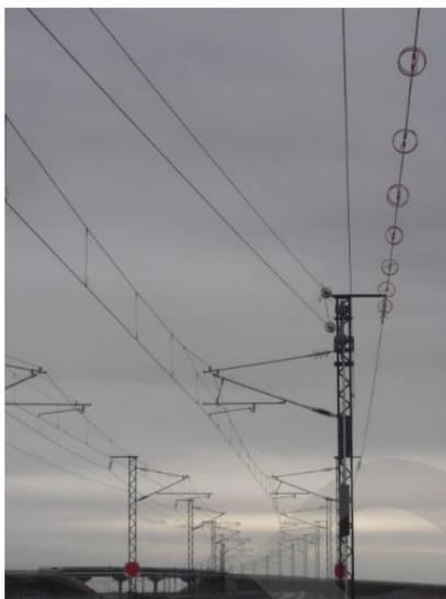
Figura 12. Dispositivos anticolidión en el cable de fíder
