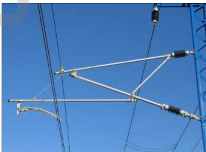
Imagen 2. Equipo de Suspensión y Atirantado Tubular.
