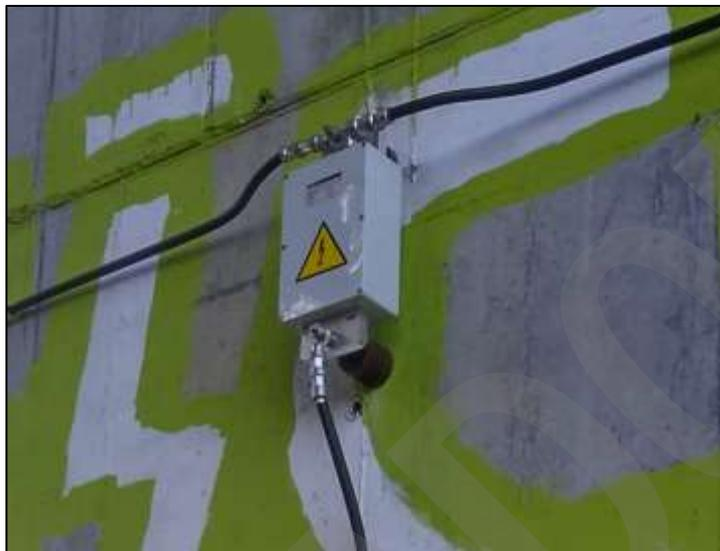
Imagen 34. Dispositivo limitador de tensión
