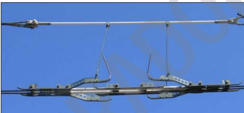
Imagen 29. Aislador de sección
