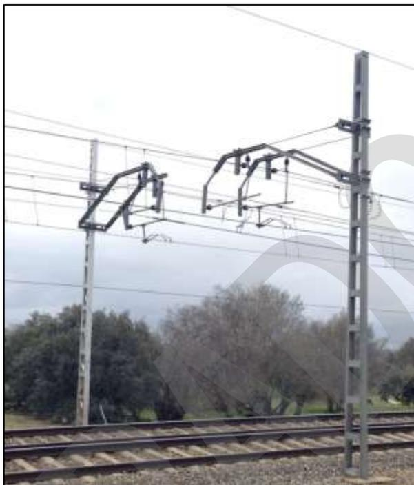
Imagen 20. Seccionamiento
