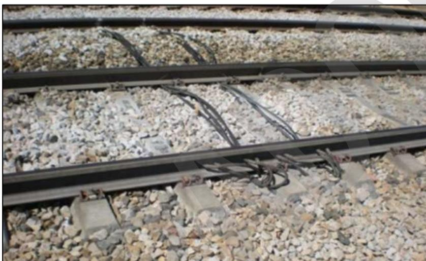
Imagen 15. Feeder negativo de corriente continua
