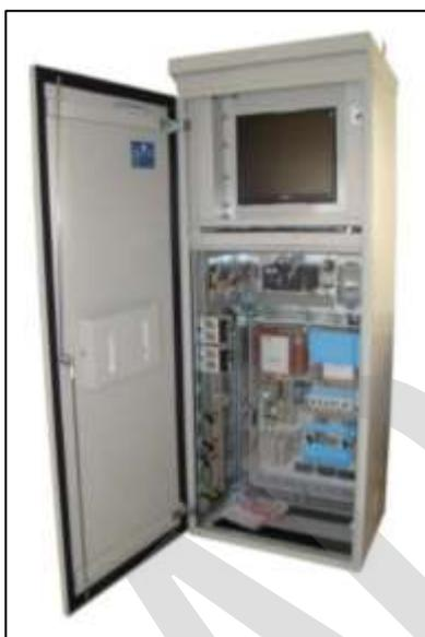
Imagen 41. Puesto local de control de seccionadores.
