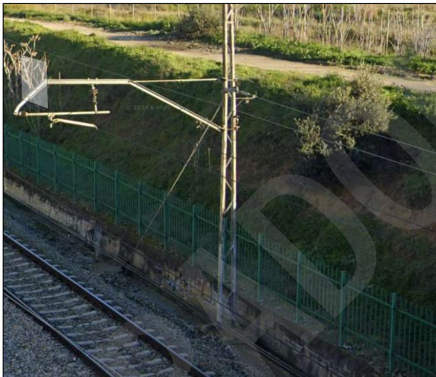
Imagen 14. Anclaje de cable de tierra/retorno
