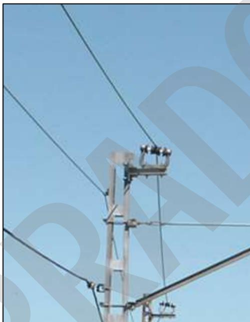
Imagen 19. Conjunto de suspensión de feeder de trayecto
