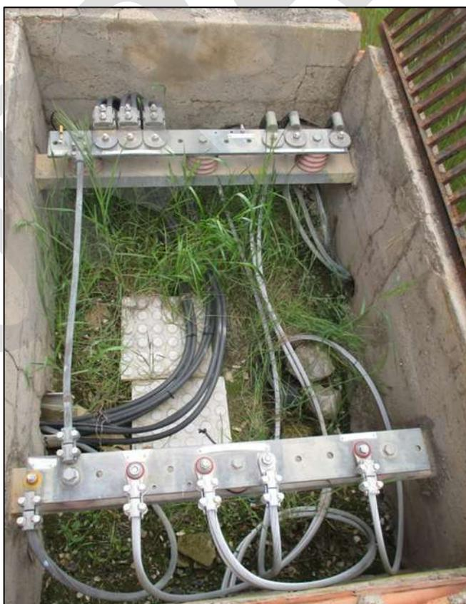
Imagen 25. Conexión de retorno a subestación
