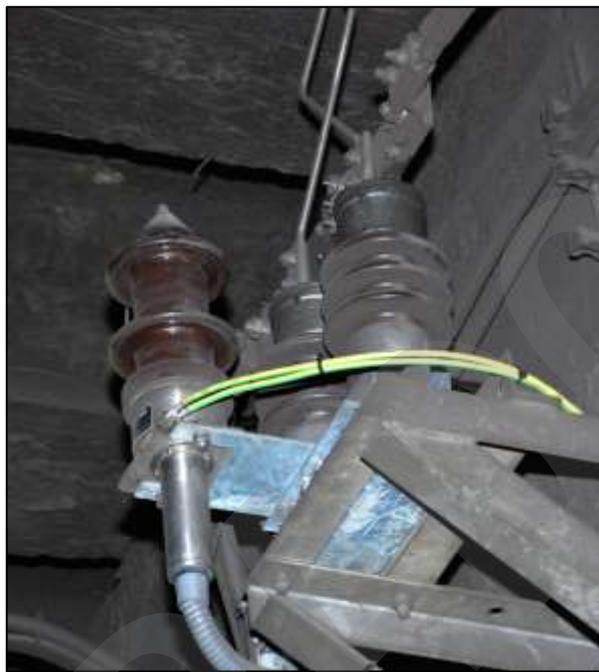
Imagen 28. Detector de tensión de seccionador
