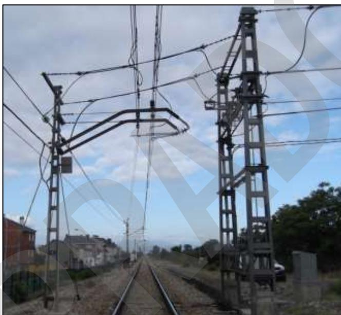
Imagen 24. Pórtico de seccionadores
