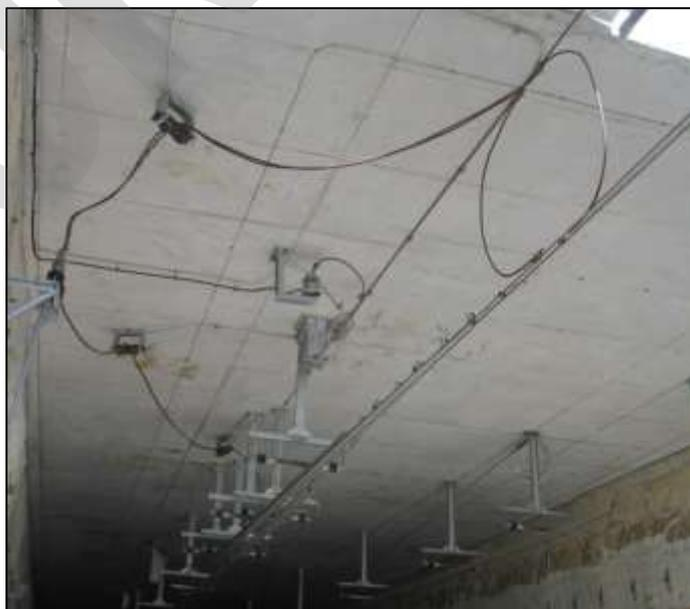
Imagen 12. Conjunto de transición de catenaria rígida
