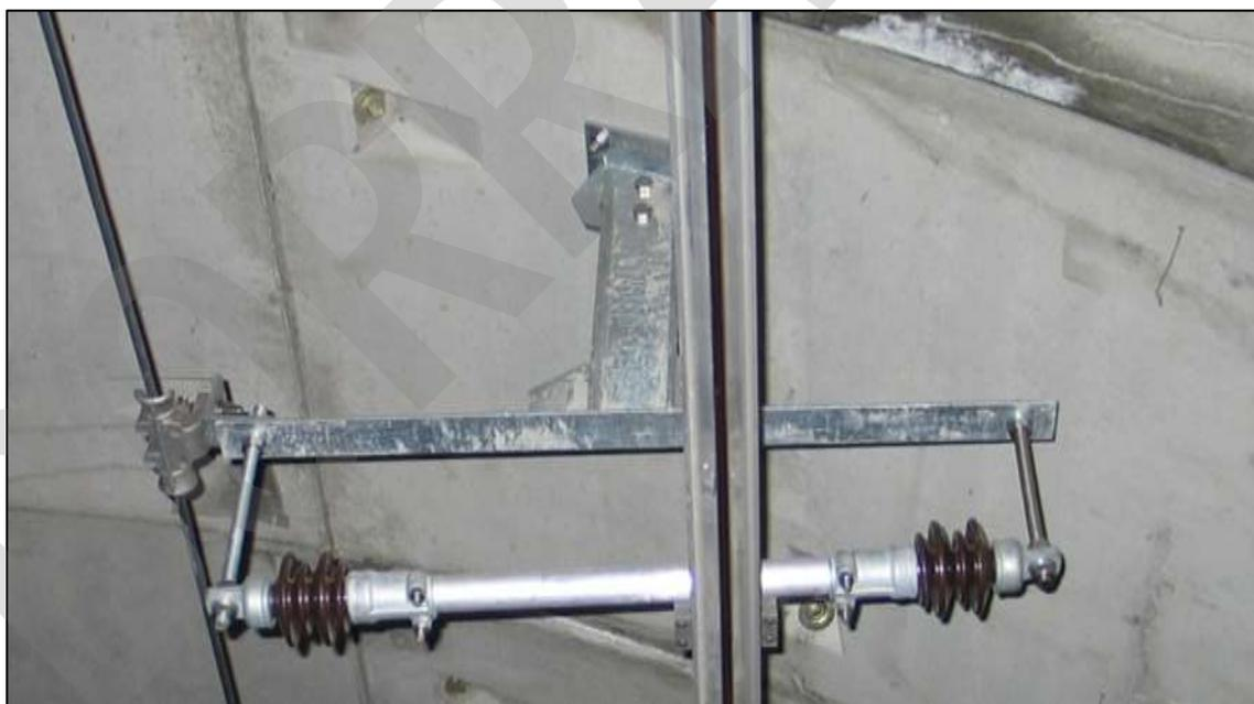
Imagen 11. Conjunto de suspensión de catenaria rígida
