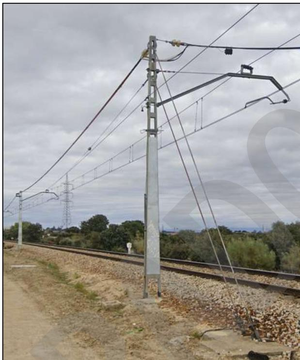
Imagen 18. Anclaje de feeder de trayecto
