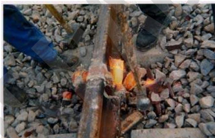
Figura 17. Retirada de la mazarota con maza.
