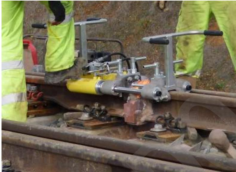
Figura 16. Rotura del molde con cortamazarotas.
