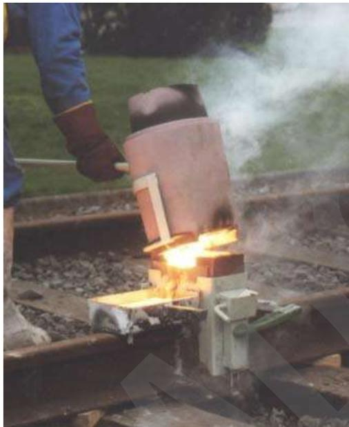
Figura 15. Ejemplo de retirada del crisol.
