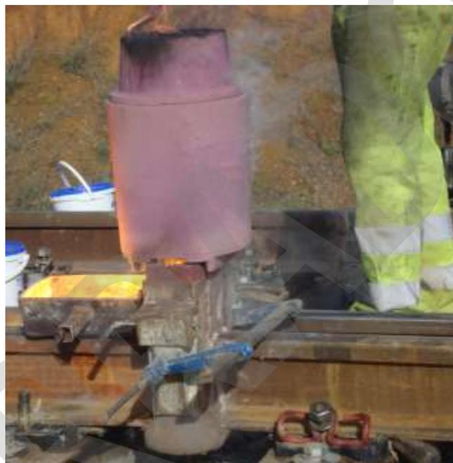
Figura 14. Ejemplo de decantación del corindón.
