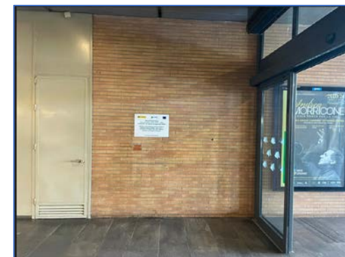
Estación de Sevilla Santa Justa Station of Sevilla Santa Justa
