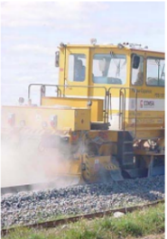
Ejemplo de trabajos de mejora de vía
