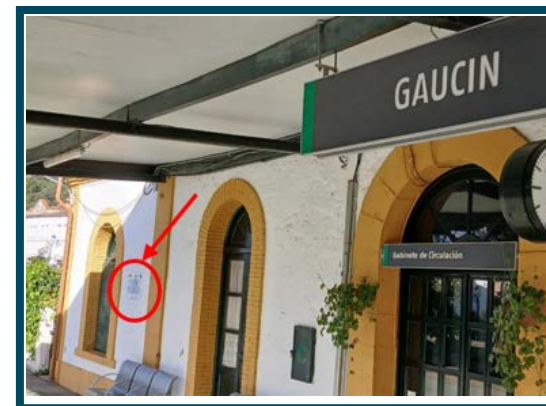
Estación de Gaucín (Málaga) Station of Gaucín (Málaga)
