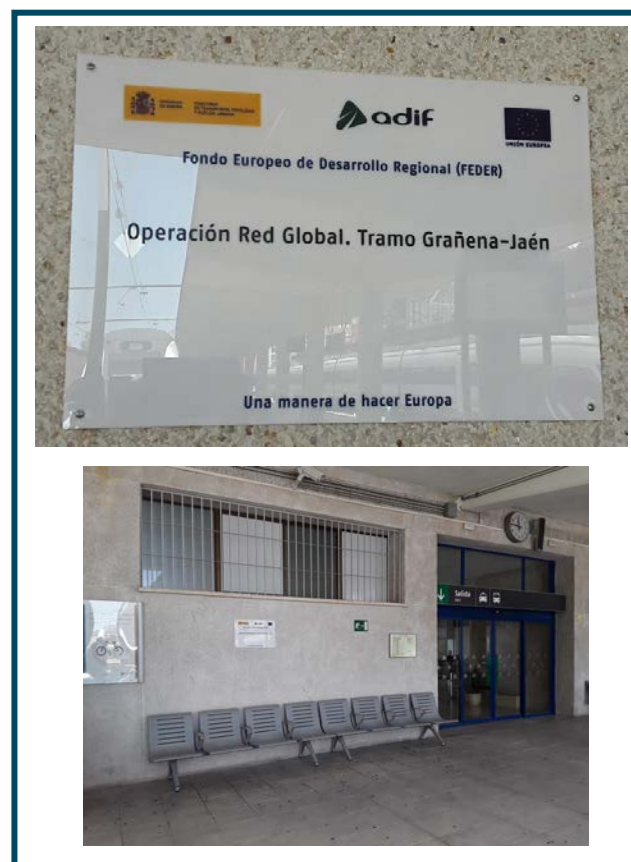
Estación de Jaén / Station of Jaén
