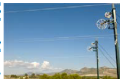
Montaje de catenaria
