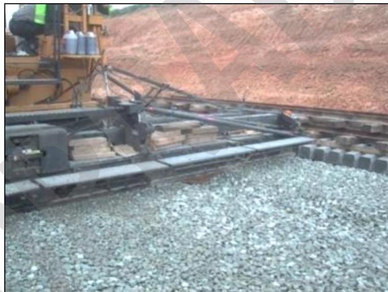
Imagen 20. Ejemplo de útil para huella acoplado en extendidora.
