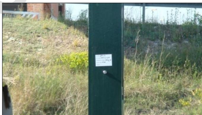
Imagen 11. Bulón roscado sobre poste de catenaria
