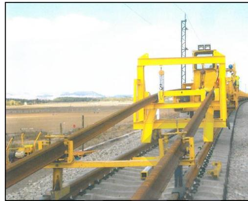
Imagen 26. Ejemplos de descarga de carril en obra.
