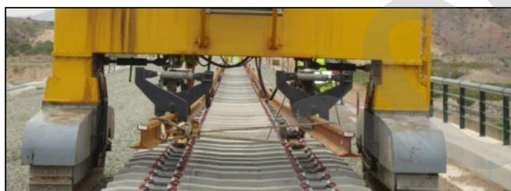
Imagen 25. Ejemplos de descarga de carril en obra.
