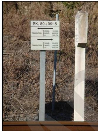
Imagen 15. Disposición general de un punto fijo en vía.
