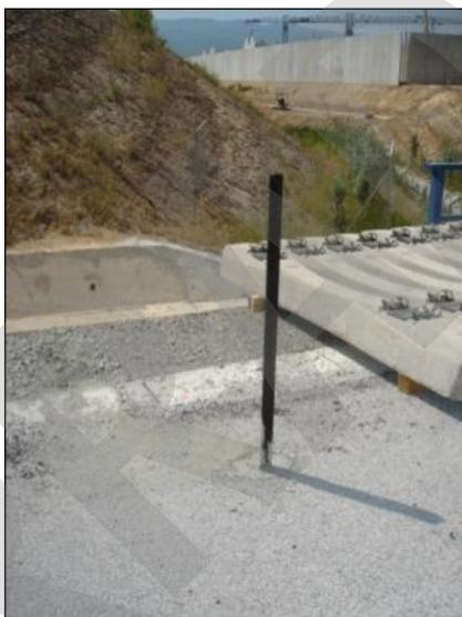
Imagen 14. Disposición general de un piquete materializado mediante angular.
