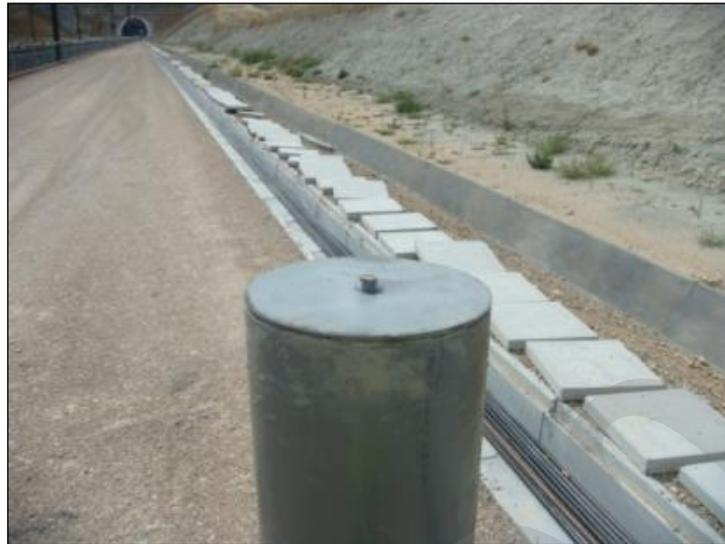
Imagen 2. Detalle de hito materializado en plataforma en tierras.
