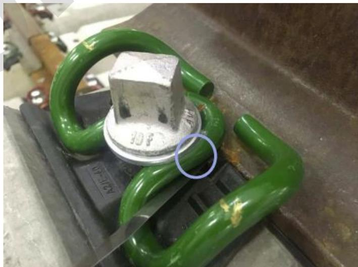
Imagen 20.- Galga midiendo el punto donde el bucle central del clip se aloja en la placa acodada (lado derecho)
