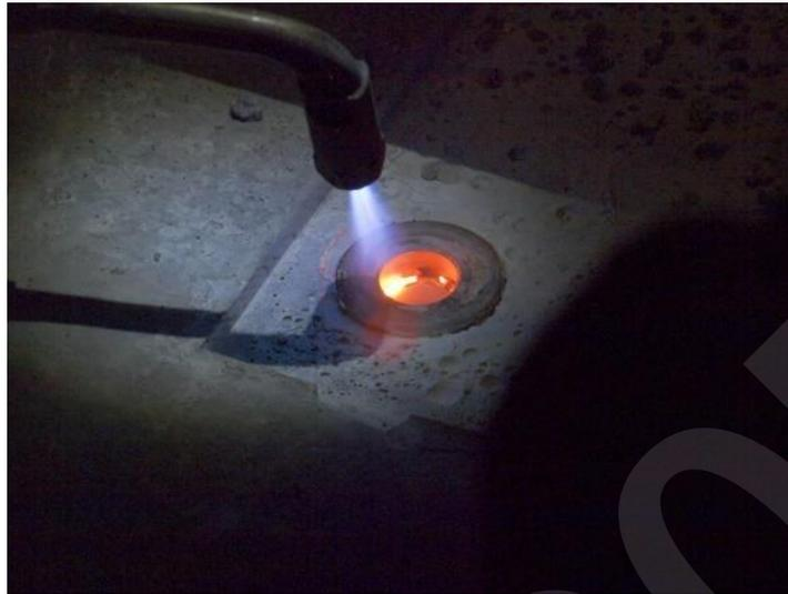
Imagen 39.- Calentado del inserto metálico.
