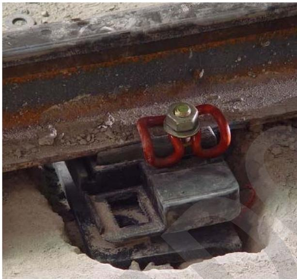
Imagen 42.- Bañeras para la colocación de las fijaciones.
