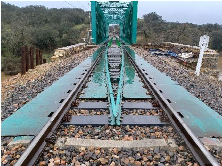
Imagen 54.- Encarriladora sobre puente metálico.
