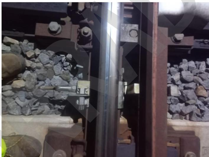
Imagen 33.- Dispositivo de seguridad para embridado de agujas no acopladas.
