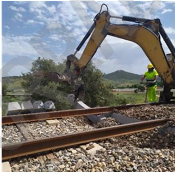
Imagen 17.- Colocación por medio de pinzas de traviesas nuevas.
