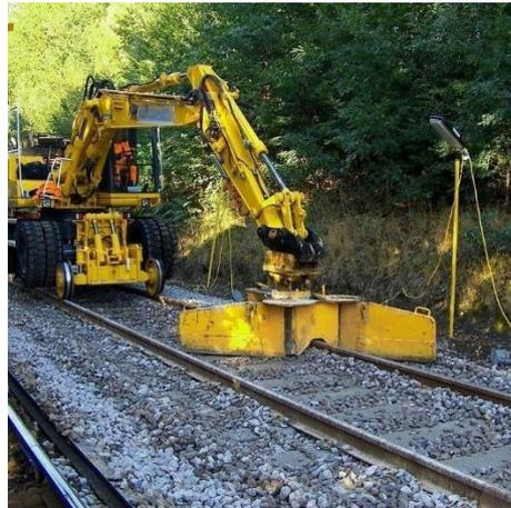
Imagen 1.- Perfilado con maquinaria bivial.
