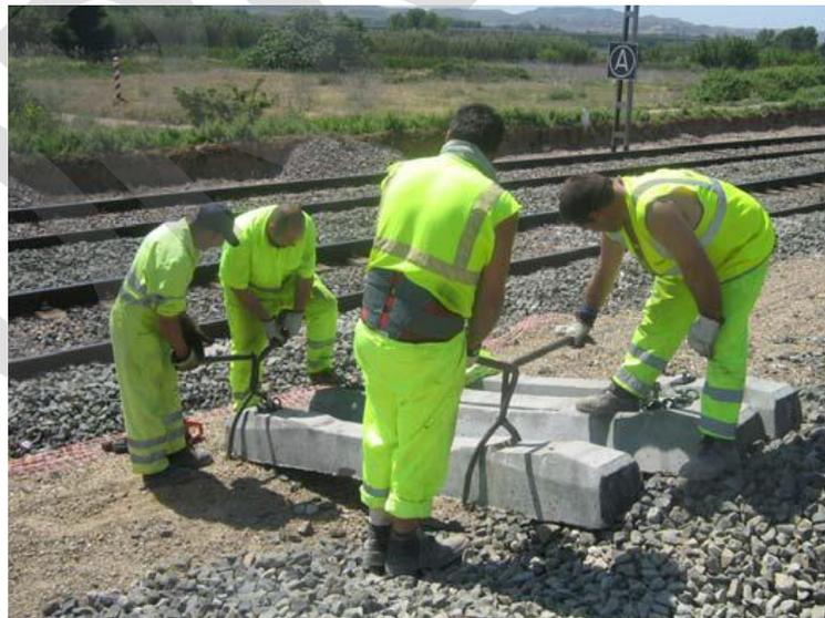
Imagen 14.- Uso de tenazas para sustitución aislada de traviesa.
