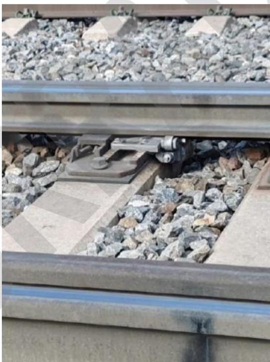
Imagen 36.- Rodillo de presión para mejora del acoplamiento.
