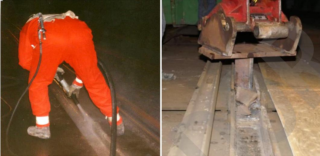
Imagen 47.-Limpieza de paredes y fondo de canaleta.
