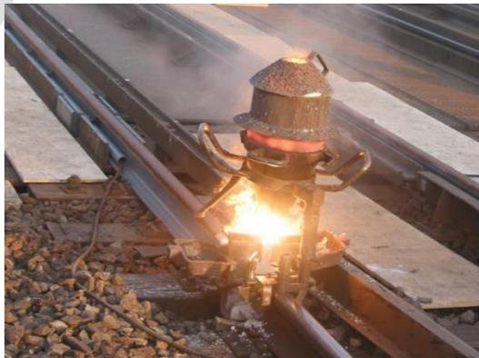
Imagen 49.- Soldadura aluminotérmica.
