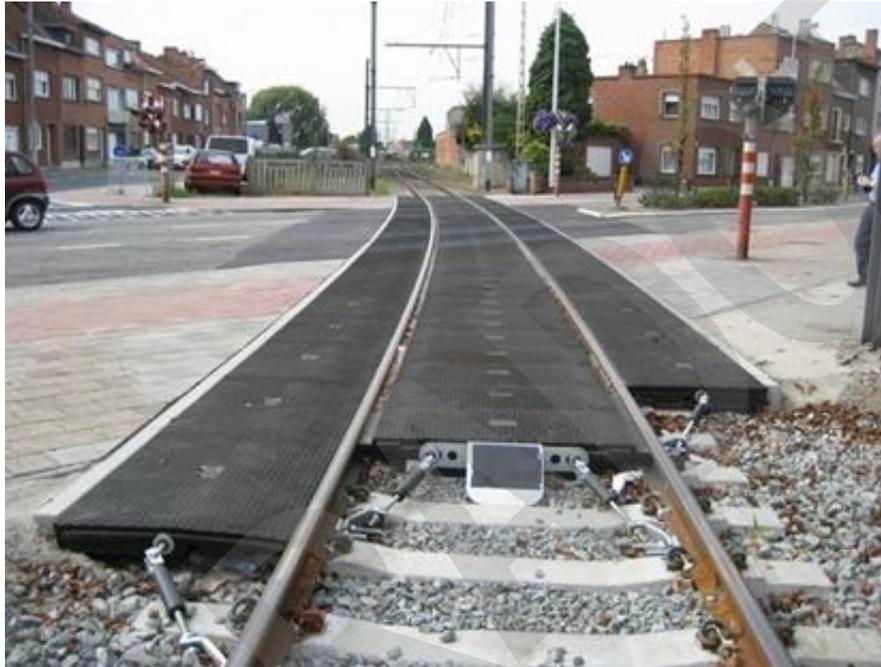
Imagen 53. - Paso nivel con panel modulares
