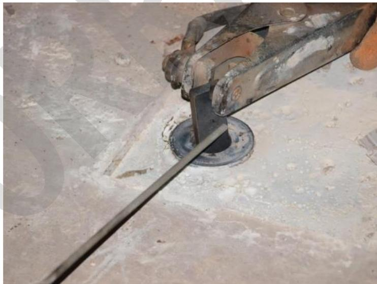
Imagen 40.- Detalle de colocación del pasamanos en la cabeza del perno a extraer.
