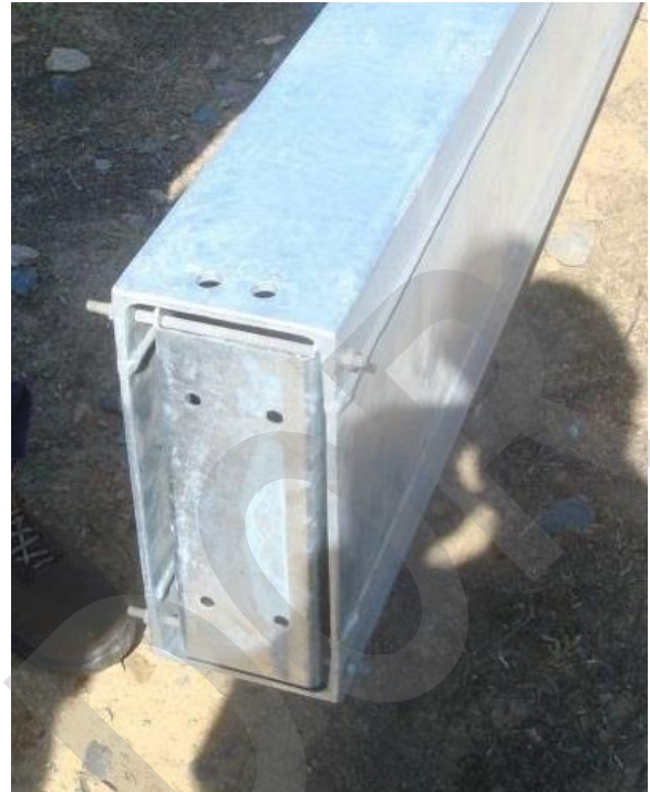
Figura 5. Chapa en U en la parte superior del poste cerrado.
