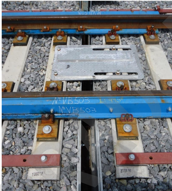
Figura 8. Junta en aparato de dilatación.
