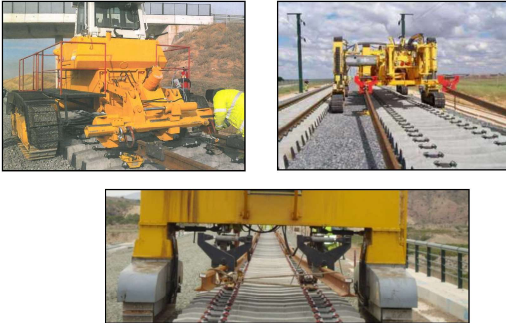
Imagen 25. Ejemplos de descarga de carril en obra.
