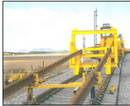
Imagen 26. Ejemplos de descarga de carril en obra.
