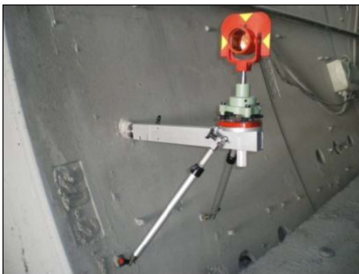
Imagen 3. Detalle de hito en hastial de túnel.
