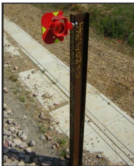
Imagen 8. Perfil metálico con punto de marcaje.
