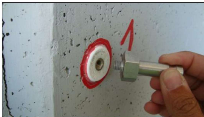
Imagen 10. Roscado de bulón sobre paramento vertical.
