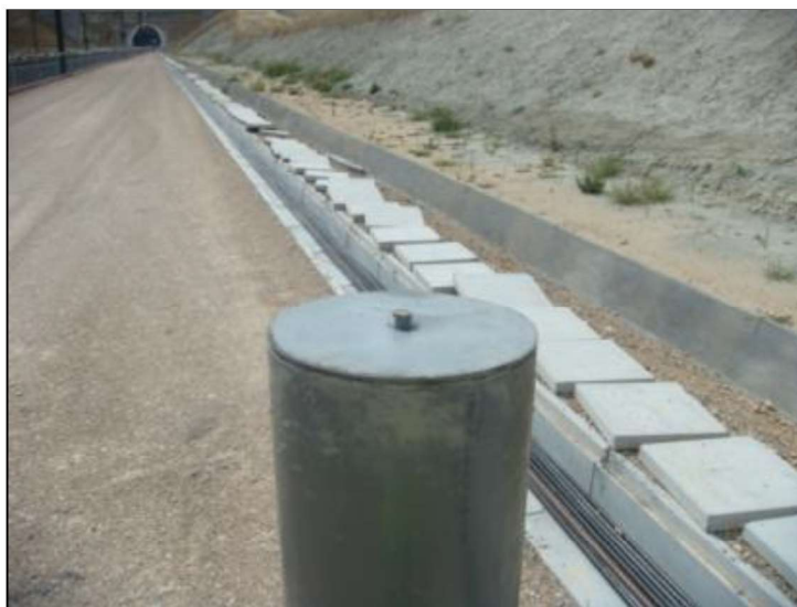
Imagen 2. Detalle de hito materializado en plataforma en tierras.
