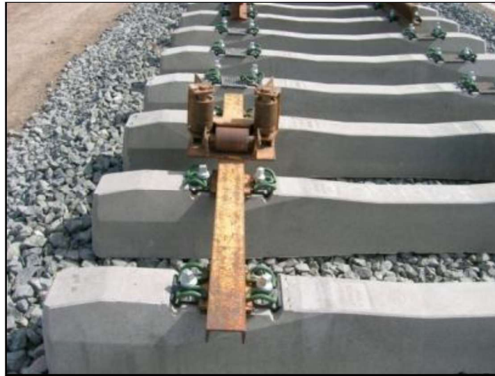
Imagen 28. Ejemplo de rodillos de deslizamiento y guiado. Vista frontal.
