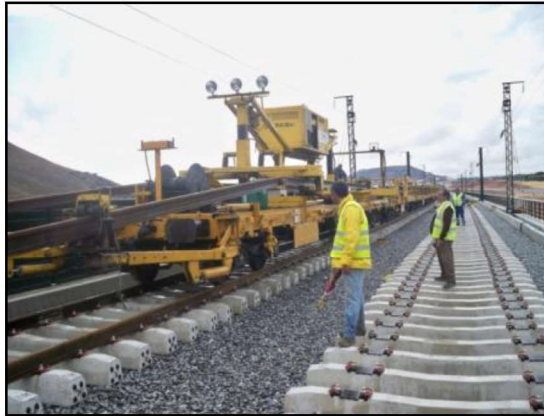
Imagen 26. Ejemplos de descarga de carril en obra.
