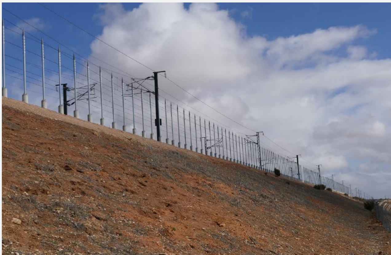
Fotografía de la pantalla experimental objeto de evaluación tras su construcción.
