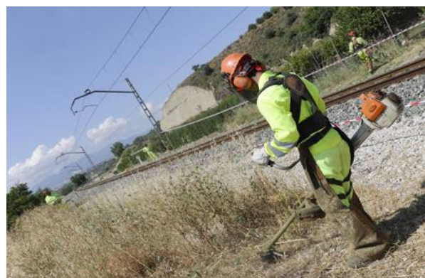
Trabajos de limpieza de la vegetación
